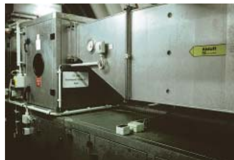
Abluftreinigungsanlage
