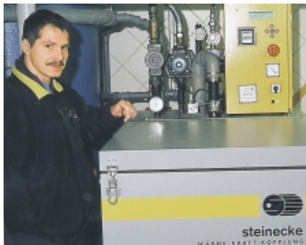
Klein und effektiv: Blockheizkraftwerke erzeugen Strom und Wärme
