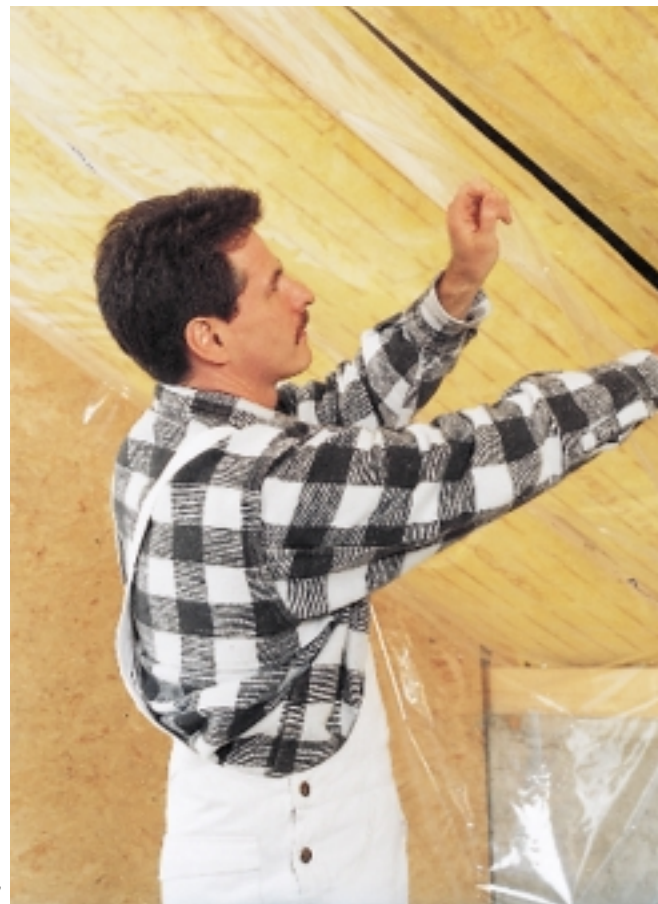
Wärmedämmung am Dach
