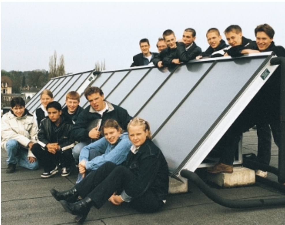
Kollektoranlage der Gesamtschule Blankenese
